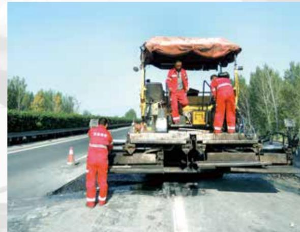
④ 作业面已经过铣刨、清扫、喷洒乳化沥青等工序，三个机手在做摊铺前的准备工作。
