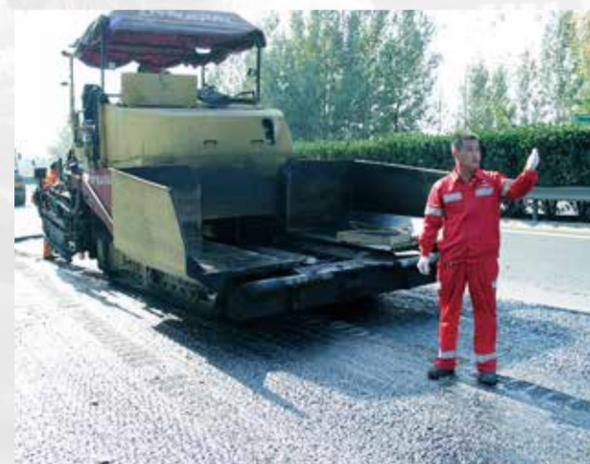
⑥ 摊铺准备工作完成，机长白兵指挥沥青混合料运输车倒车卸料。
