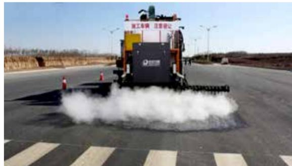
图 1 沥青路面环保型融冰雪涂层试验路施工
