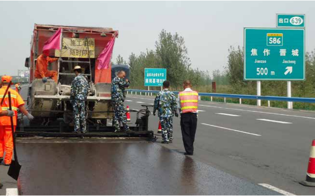
■万里路桥京港澳高速高粘低噪微表处预防性养护施工
