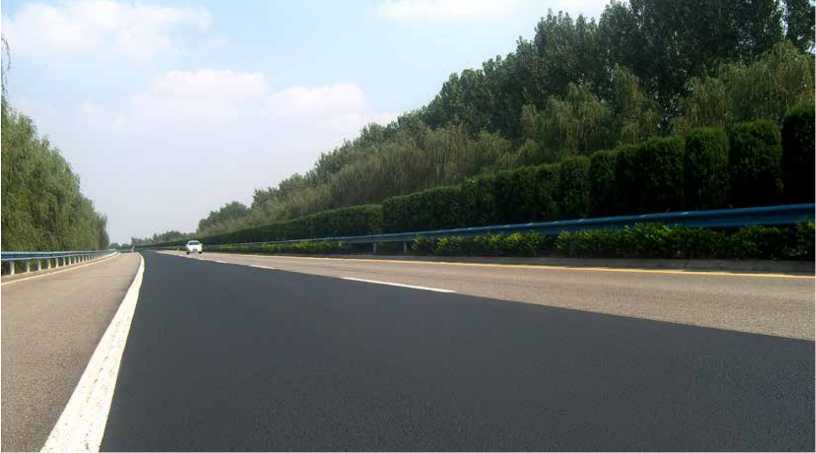
■万里路桥连霍高速环氧聚合物磨耗层预防性养护施工效果
