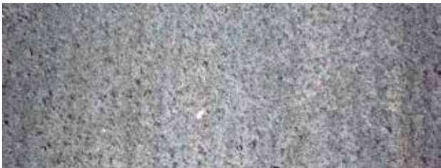
低噪声微表处施工路面集料分布照片
