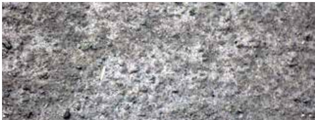
普通微表处施工路面集料分布照片
