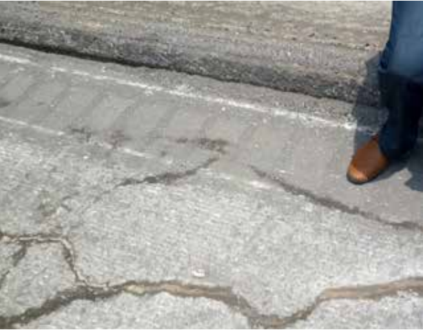
■万里路桥安徽合徐南高速高强聚合物注浆施工效果
