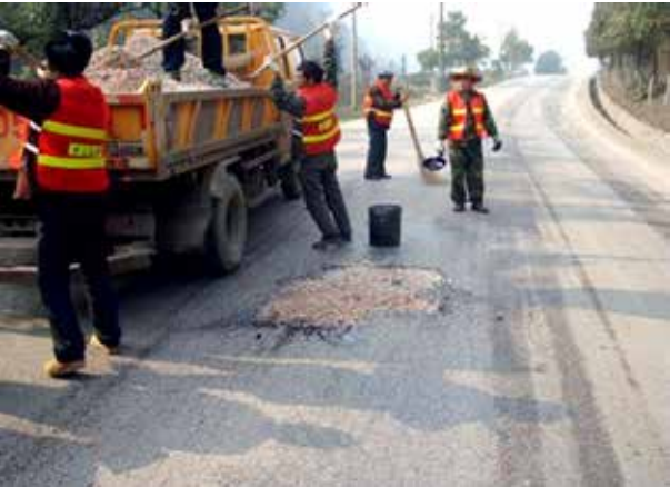
图 3：坑槽修补照片 2
