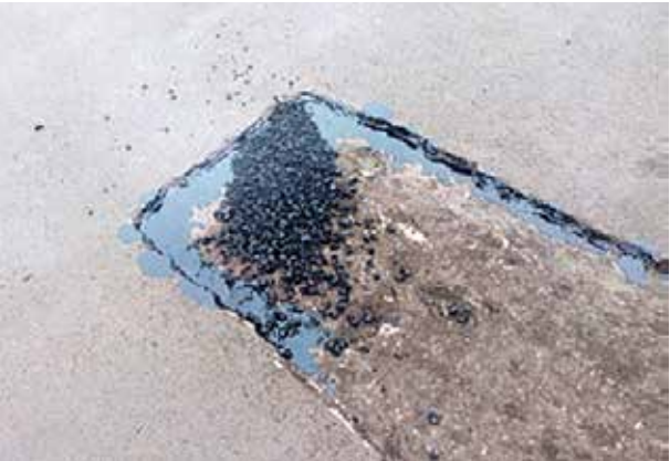
图 2：坑槽修补照片 1
