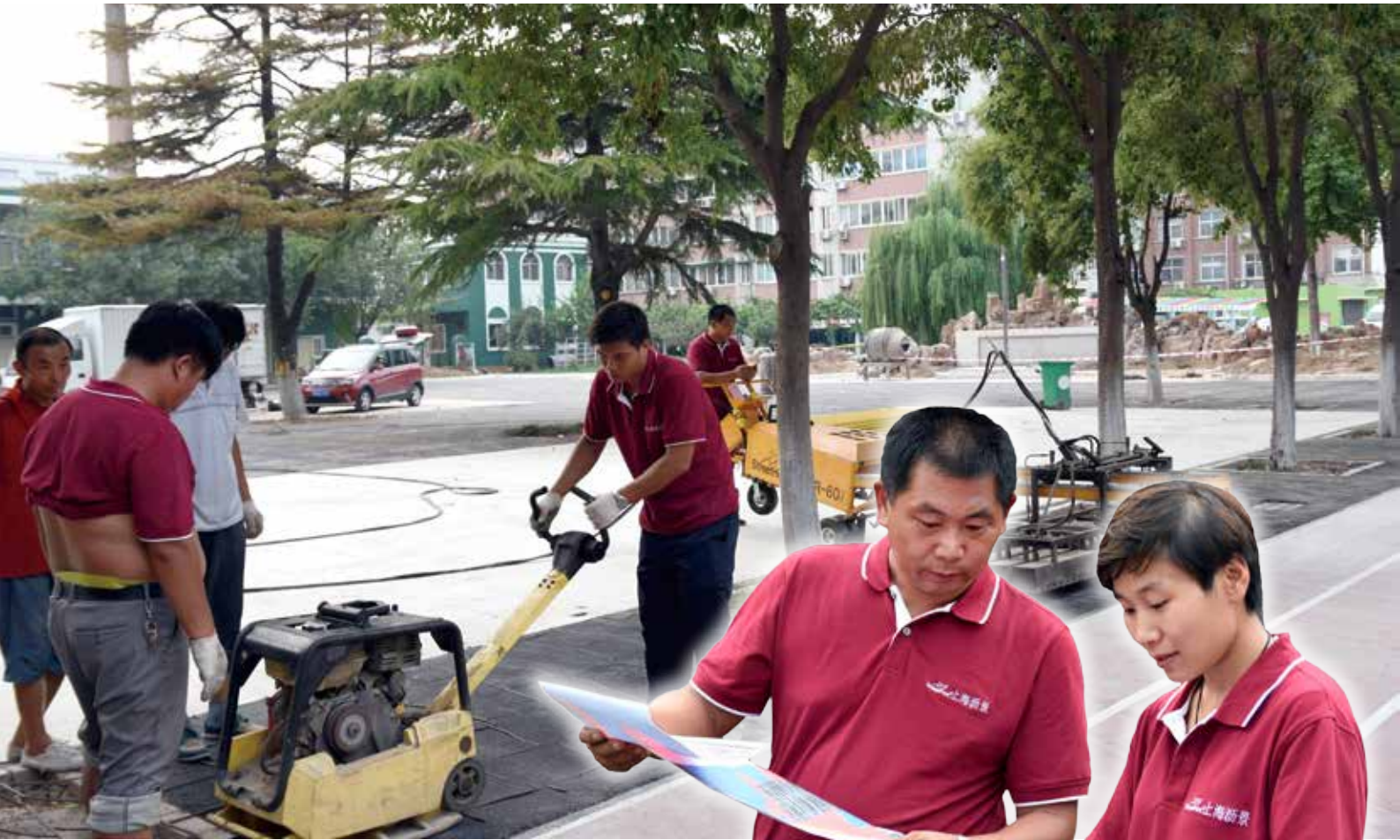
► 路面加热与模压两道工序要紧密衔接，颜子龙与杨晓军交叉配合十分默契。
