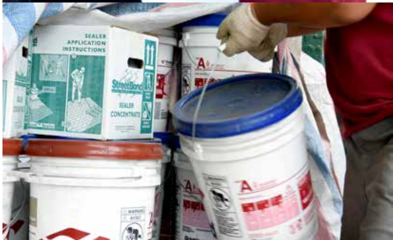
► 材料仓库内，整齐摆放着工程所需颜料、底层涂料、面层涂料、面层保护膜等各种 StreetBond 原装材料，工人取出材料准备预拌。
