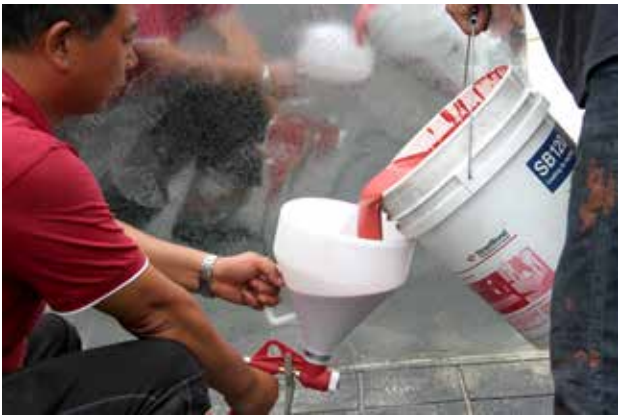
► 将 SB 颜料加入底层涂料，使用机械设备搅拌均匀，然后添加到喷涂装置，准备喷涂施工。
