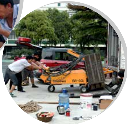
► 颜子龙换上专用工服，开始喷涂工序，杨晓军带领工人迅速涂抹，让涂料均匀渗入路面。经过底层、面层 2 次涂装之后，再喷涂面层保护膜，才完成整套 SP 路面彩绘工艺。随着他们紧张的工作，育才幼儿园逐渐旧貌换新颜。
