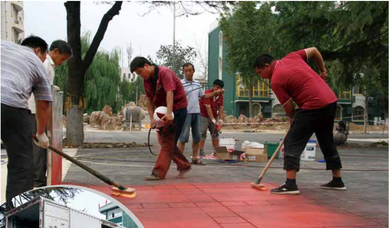
► 颜子龙换上专用工服，开始喷涂工序，杨晓军带领工人迅速涂抹，让涂料均匀渗入路面。经过底层、面层 2 次涂装之后，再喷涂面层保护膜，才完成整套 SP 路面彩绘工艺。随着他们紧张的工作，育才幼儿园逐渐旧貌换新颜。
