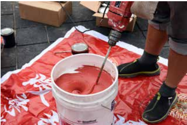
► 将 SB 颜料加入底层涂料，使用机械设备搅拌均匀，然后添加到喷涂装置，准备喷涂施工。
